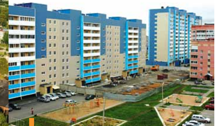
Жилой комплекс «Седьмое небо»: жилой дом № 14-а, Б, В по генплану в 112 мкр., 3-й этап строительства – жилой дом № 14 В в осях 7-9, г. Череповец, Октябрьский проспект, д. 82 (ООО «Железобетон-12»)
