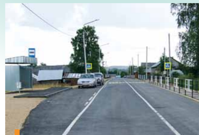
Реконструкция автодороги Слуда-Афанасьевская в Тарногском районе (ОАО «Вологдавтодор»)
