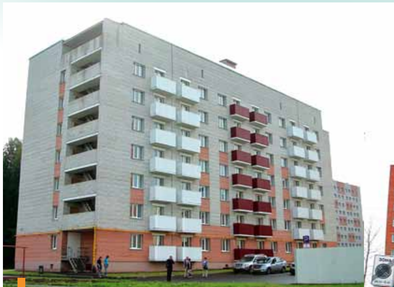
84-квартирный жилой дом для обеспечения жильем детей-сирот, Октябрьский пр., 80, г. Череповец (ООО «Горстройзаказчик»).
