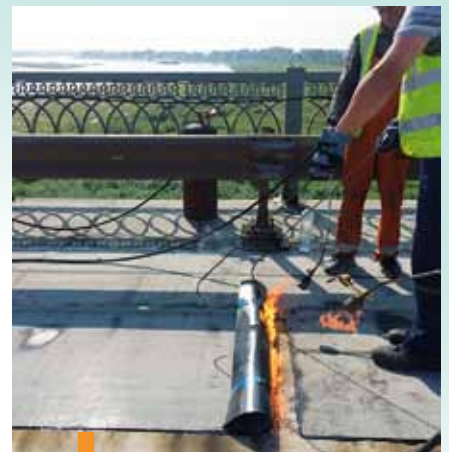
Ремонт моста через р. Сухону, г. Великий Устюг (ООО «Мостостроительный отряд №61»).
