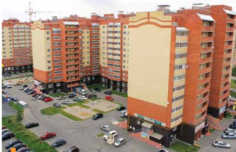
13-этажный 571-квартирный дом, г. Череповец, Шекснинский пр., 16 (ООО «РЕАЛ-СВ»).
