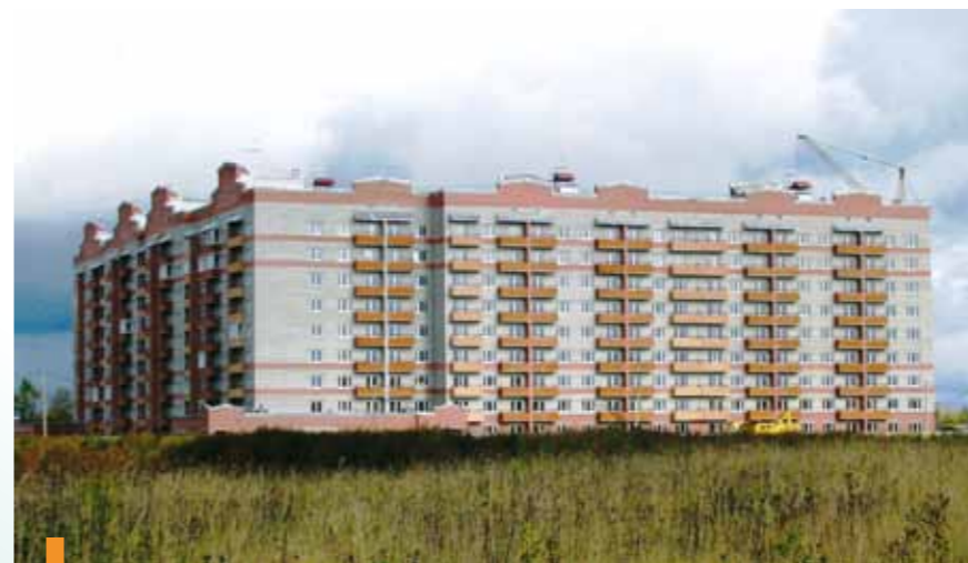
Жилой дом № 4 в микрорайоне Южный, г. Вологда (ООО «ВологдаСтройЗаказчик»).
