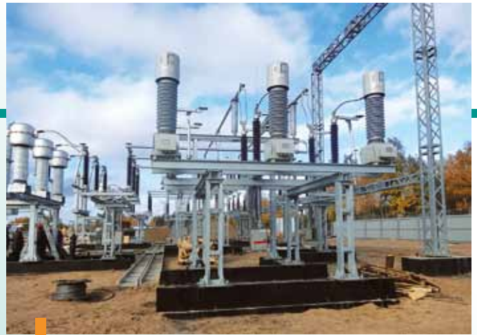
Монтаж металлоконструкций открытых распределительных устройств (ООО «ПромСтрой»).
