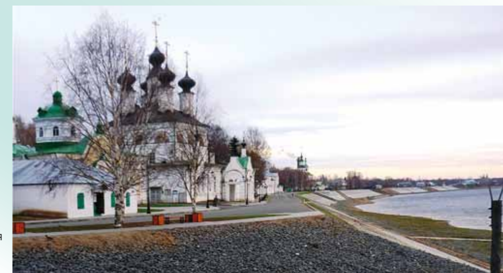
Реконструкция улицы Набережная в г. Великий Устюг (ОАО «Вологдавтодор»).
