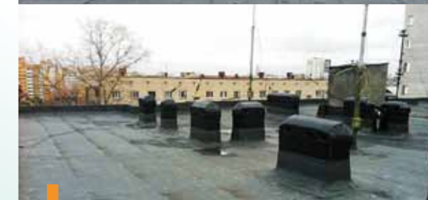
Капитальный ремонт дома, ремонт кровли, г. Вологда: ул. Конева, 33; ул. Южакова, 30 (ООО «Строительная компания «Арбат»).
