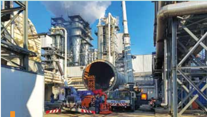
Монтаж ДСП-400 (ООО «Метако»).
