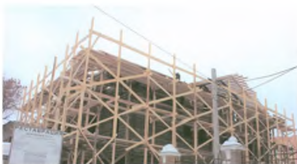
РЕСТАВРАЦИЯ ЖИЛОГО ДОМА XIX ВЕКА Адрес: г. Вологда, ул. Благовещенская, д. 20
