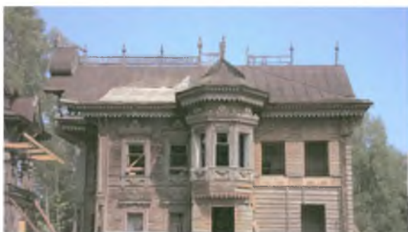
РЕСТАВРАЦИЯ ЖИЛОГО ДОМА Адрес: Костромская обл., д. Осташево
