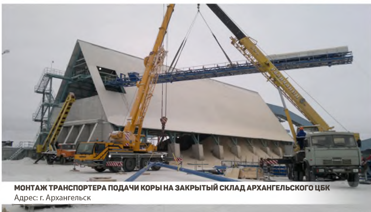
МОНТАЖ ТРАНСПОРТНОЙ ГАЛЕРЕИ ПОДАЧИ ЩЕПЫ НА СКЛАД Адрес: г. Архангельск
