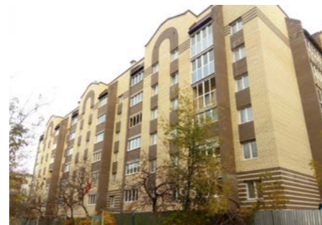
Многоквартирный жилой дом, г. Череповец, Гоголя, 14, ООО «РЕАЛ-СВ-1»
