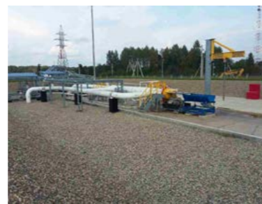
Замена камер пуска и приема СОД Ду800 на ППМН р.Сухона Магистральный нефтепровод «Ухта-Ярославль» «СтройТЭК»
