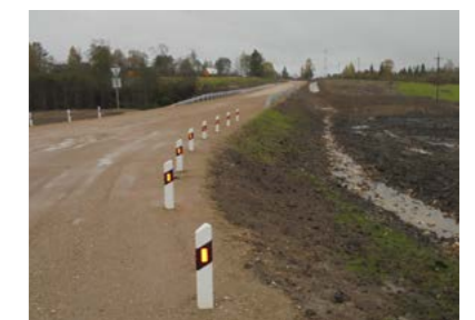
Строительство подъезда к посёлку Нижне-Кубенский Харовского муниципального района ПАО «Вологдавтодор»
