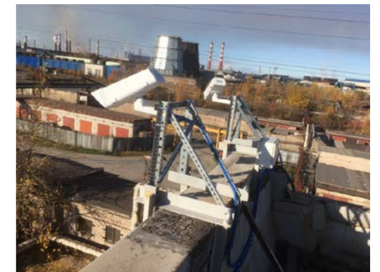
Установка системы видеонаблюдения. ПАО «Северсталь», Центр «Домнаремонт» ООО ИТЦ «Витэкс»
