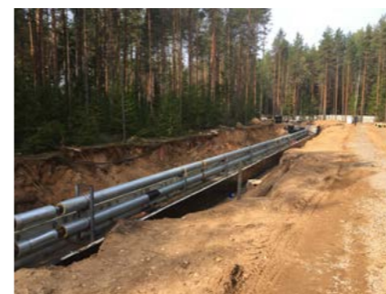
Реконструкция тепловых сетей б/о Сосновка АО «Апатит» ООО «Новая энергетика»
