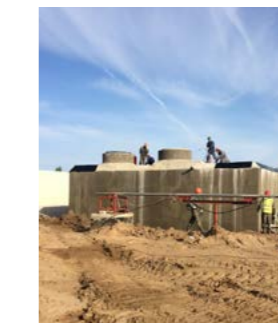
Строительство «Лесопильного завода», Белозерский р-он ООО «МонолитСтальСтрой»
