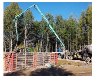
Строительство РП в 108 мкр. МУП «Электросеть»
