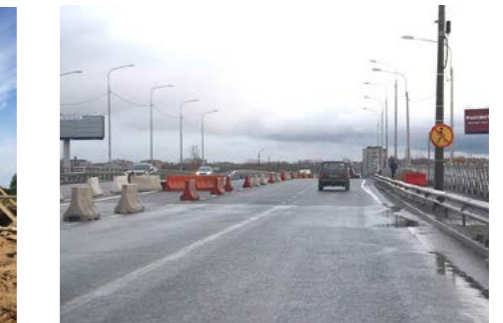
Ремонт Северного моста, г. Череповец ООО «Мостоотряд № 61»
