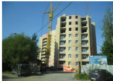
Строительство жилого комплекса «Кристалл» в 23 мкр., г. Череповец ООО «Горстройзаказчик»
