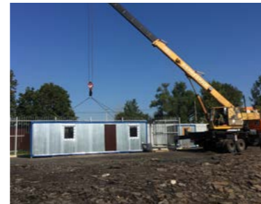
МО, Химки, подготовка стройплощадки ООО «ГАРАНТСТРОЙ»
