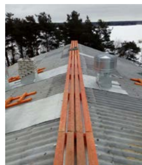
Капитальный ремонт крыши ООО «ЗемСтрой»
