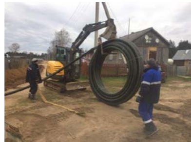
Прокладка газопровода низкого давления из полиэтиленовых труб ПЭ 100 Ду 110 мм АО «Газпром газораспределение Вологда»
