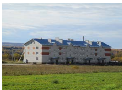
42-квартирный жилой дом по адресу: Вологодская область, Вытегорский район, ул. Академика Бараева ООО «СКВ»
