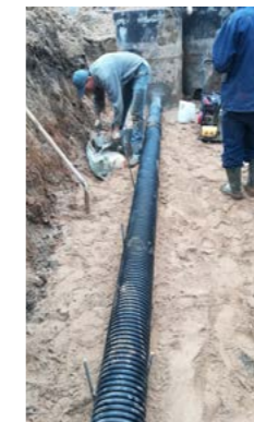
Строительство сети водопровода и канализации по ул. Широкая МУП «Водоканал»
