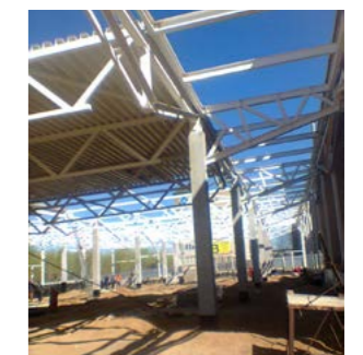
Строительный контроль ООО «Промстройэкспертиза»
