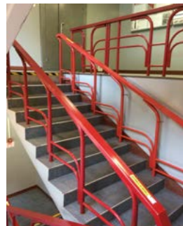
Лестничный марш АБК КАДП Чугун ООО «ГЕОСТРОЙ»
