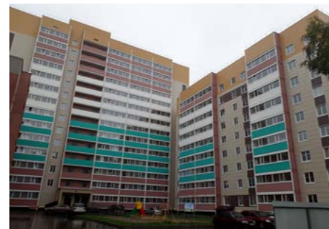
Жилой дом по ул. Песчаной в 21 мкр. г. Череповца (№1 по генплану), 1, 2, 3 секции ООО «Железобетон-12»
