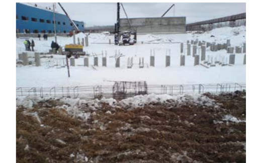
Строительство котельной, ЧФМК ООО «КОМГАЗЭНЕРГО»
