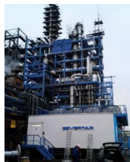
Сервисное обслуживание (ремонт, замена) технологического оборудования и трубопроводов ООО «Индусерв»
