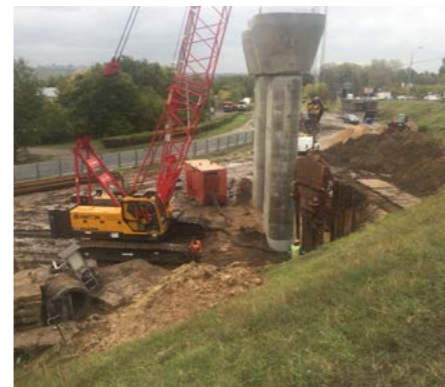
Бурение лидерных скважин, погружение шпунта Ларсена, устройство анкеров Буран 52/28 ООО «Виктория»
