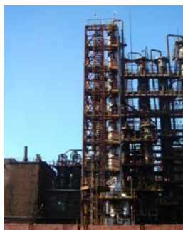
Монтаж сероуглеродной колонны. ПАО «Северсталь», ЦПХП №1 ООО «РКХО»
