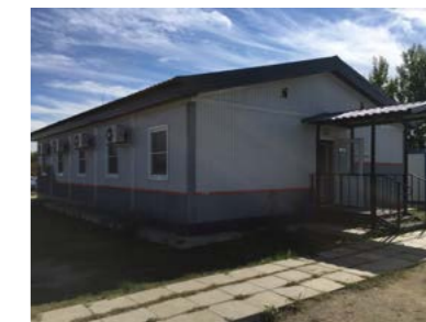
Монтаж штаба строительства на базе блок-модулей под ключ ООО «ТМК»
