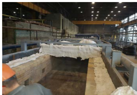
Футеровка проходной печи малоокислительного нагрева и ванны расплава свинца. Агрегат №2 в СПЦ-2 ОАО «Северсталь-метиз» «Сервисстройремонт»
