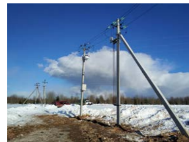
Техническое перевооружение ВЛ 10кВ для нужд ВЭС в части установки реклоузеров ООО «СТЭЛС»
