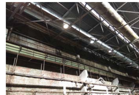
Теплоизоляционные работы, АО «Северсталь-Метиз» ООО «ЧЭТС»
