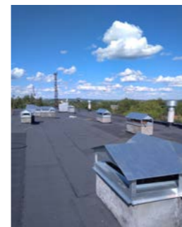
Капитальный ремонт кровли, ул. центральная, 13 ООО «СК Арбат»
