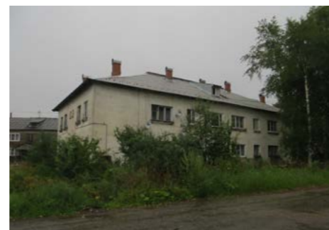
Капитальный ремонт кровли р.п. Коноша ООО «ИдеалСтрой»
