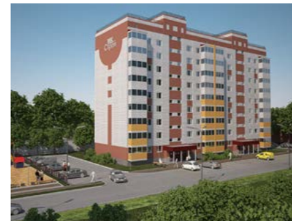
Многоквартирный жилой дом по Осановскому проезду, д. 14-а в г. Вологда ООО «МК-строй»
